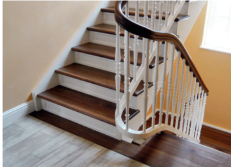
/ Basis für die rationelle Sanierung dieser Treppe war ein hochpräzises 3D-Laseraufmaß.
